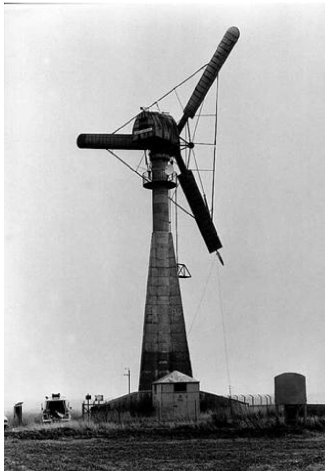
Figura.- Aerogenerador Gedser de 200 kW
